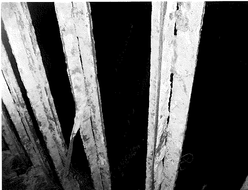
MONTANTI STRUTTURALI ENTRO CASSE
