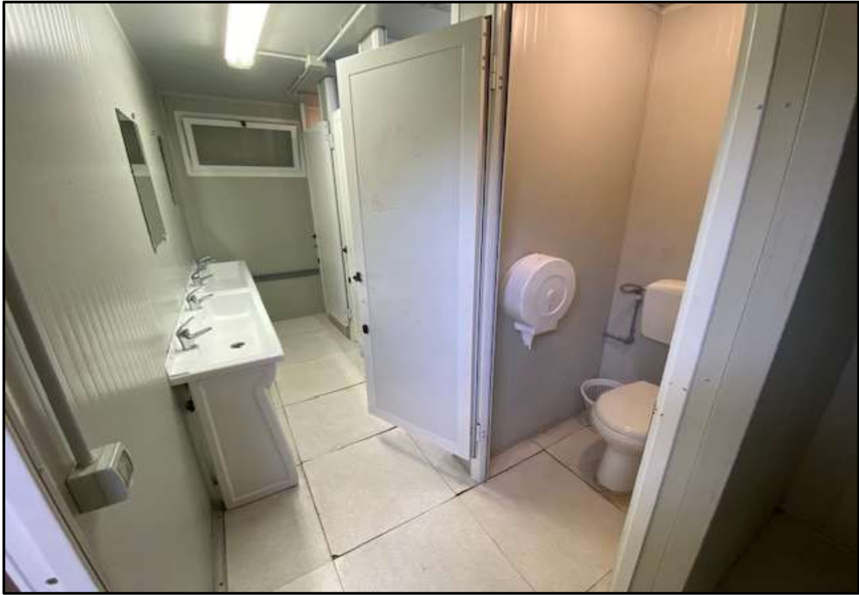
Fotografia n.3 – Interno Gruppo Bagni
